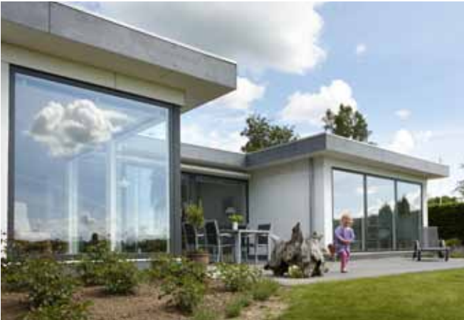
VELFAC 200 fönster i renoverad 70- tals villa. Färg: RAL 7016
