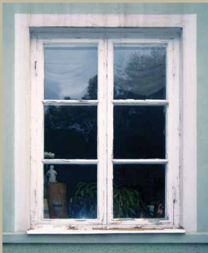
► Gammalt träfönster före fönsterbyte.
