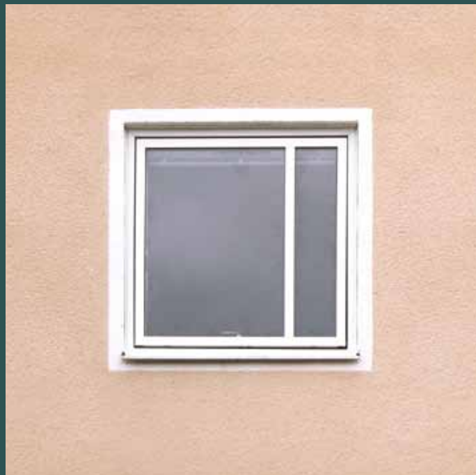
► Montage av VELFAC 200i i befintlig karm. Den gamla karmen har klätts med aluminium.
