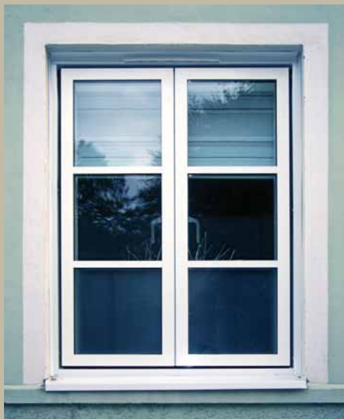
► Montage av VELFAC 200i i befintlig karm. Den gamla karmen har klätts med aluminium.
