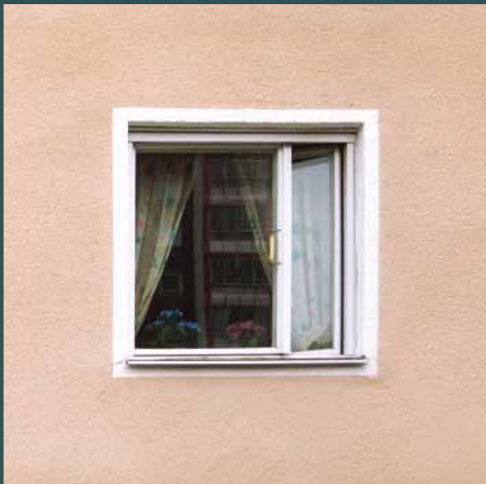
► Gammalt träfönster före fönsterbyte.
