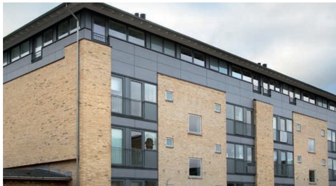
Kagshusene, Brønshøj. 297 lejligheder Boligforening: Postfunktionærernes Andels-Boligforening (PAB) Arkitekt: DOMUS Arkitekter Opført: 1950'erne Vinduer: VELFAC 200 og VELFAC 100
