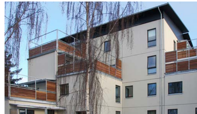
Nivåhøj III, Nivå. 184 lejligheder fordelt på 11 punkthuse Boligforening: Boligforeningen VIBO, afd. 103, Nivåhøj Arkitekter: Arkitektfirmaet Friborg og Lassen Opført: 1980-1982 Vinduer: VELFAC Ribo
